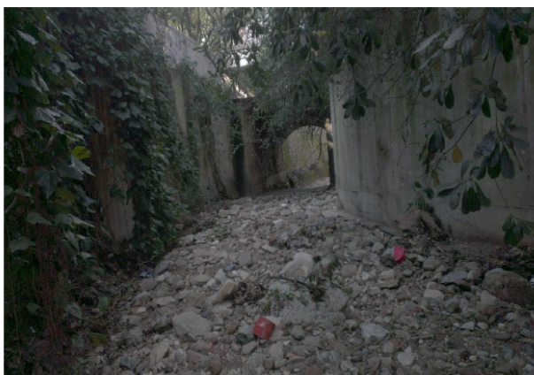
Φωτ. 4.3: Πλευρικοί κατακόρυφοι τοίχοι από οπλισμένο σκυρόδεμα.
