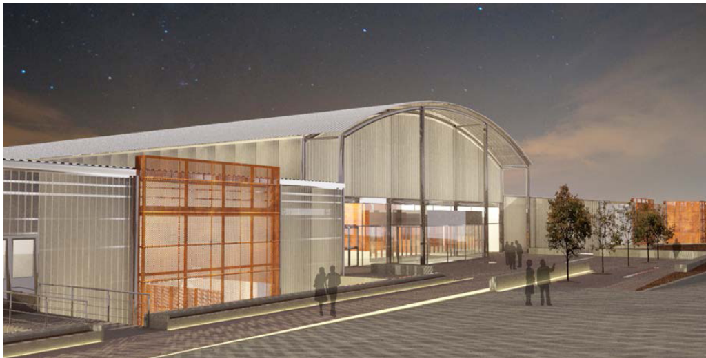
Εικόνα 5.2: Άποψη της κεντρικής εισόδου με την πεζογέφυρα όδευσης διαφυγής αριστερά της εικόνας και δεξιότερα η ενσωμάτωση, των κλιματιστικών μονάδων σε αρχιτεκτονική προεξοχή με επικάλυψη από διάτρητα φύλλα αλουμινίου.
