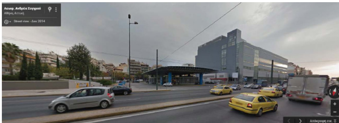
Εικόνα 4.4.2: Γενική άποψη του Σταθμού Μετεπιβίβασης Συγγρού-ΦΙΞ από το ρεύμα καθόδου της Λεωφόρου Συγγρού, από τα αριστερά προς τα δεξιά, φαίνεται τμήμα του Πάρκου Ελλήνων Ολυμπιονικών, το στέγαστρο του υπέργειου τμήματος του Σταθμού Μετεπιβίβασης και το κτίριο ΦΙΞ (Google StreetView, 2016).
