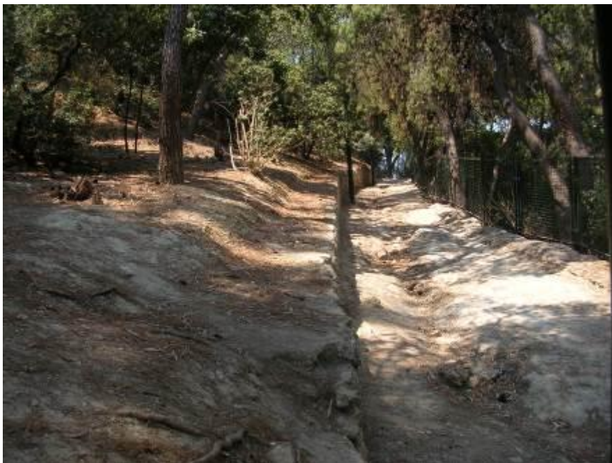
α) Υφιστάμενη κατάσταση
