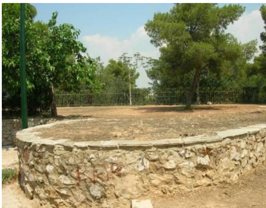
α) Υφιστάμενη κατάσταση
