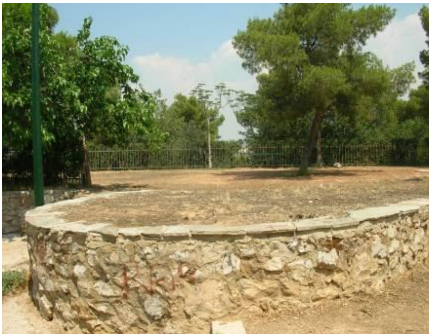
α) Υφιστάμενη κατάσταση
