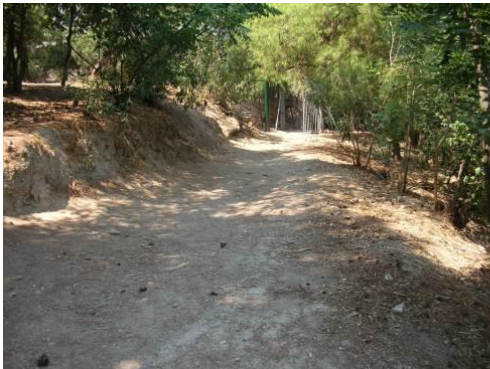
α) Υφιστάμενη κατάσταση
