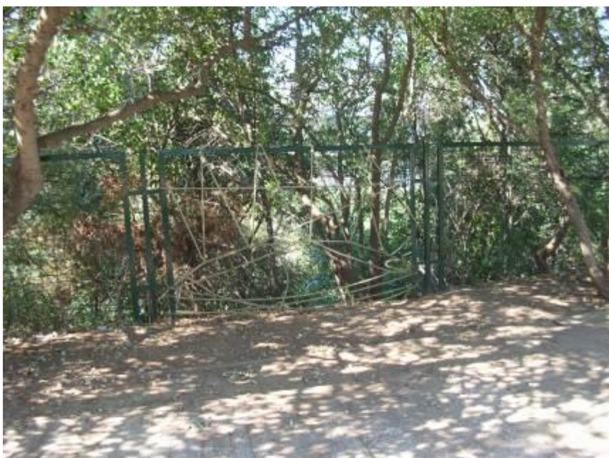
Επισκευή υφιστάμενης μεταλλικής περίφραξης
