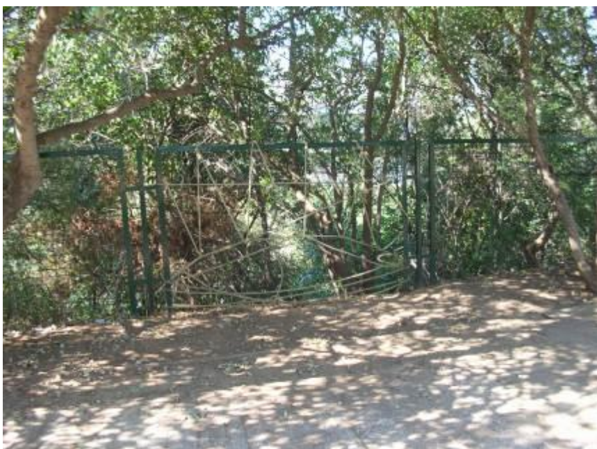
Επισκευή υφιστάμενης μεταλλικής περίφραξης
