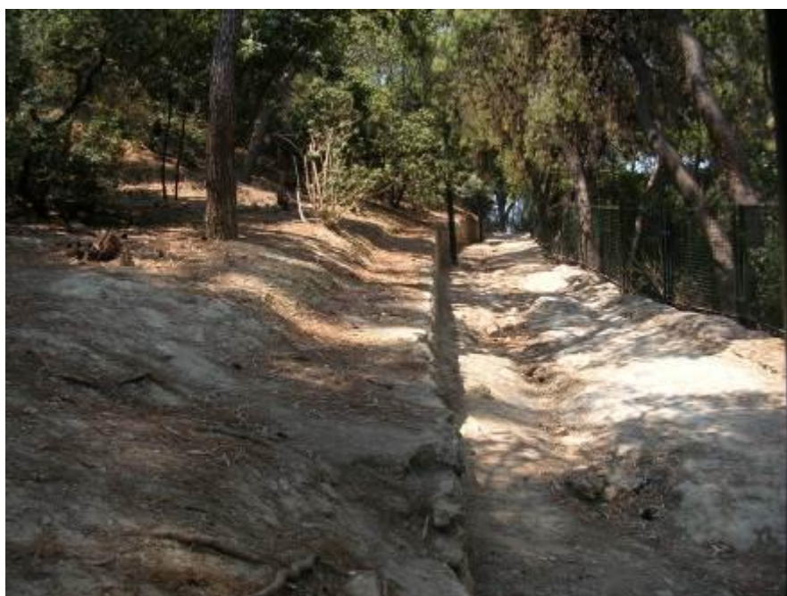
α) Υφιστάμενη κατάσταση
