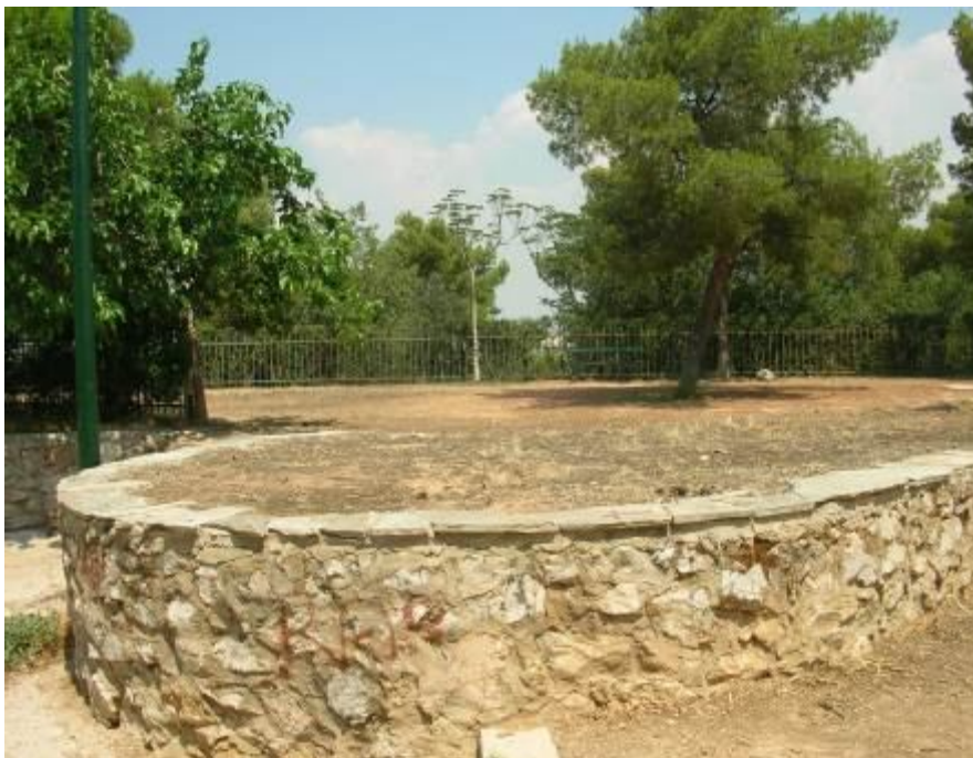
α) Υφιστάμενη κατάσταση
