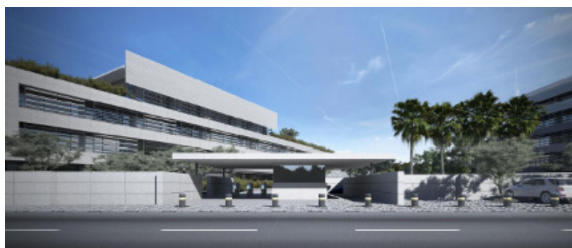
Εικόνα 5.2: Άποψη του νέου φυλακίου και του νέου κτιρίου από την οδό Αρτέμιδος.
