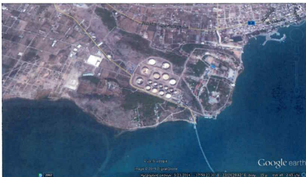
Εικόνα 1. Απεικόνιση των εγκαταστάσεων Δεξαμενών Μεγάρων και της ευρύτερης περιοχής
