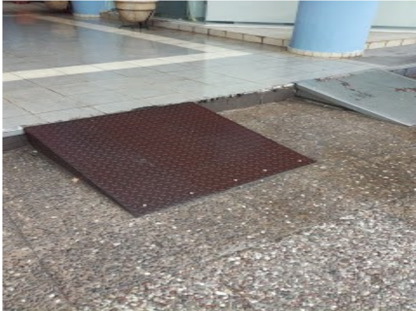
Ράμπες στην είσοδο του κτιρίου της Περιφέρειας Δυτικής Αττικής
