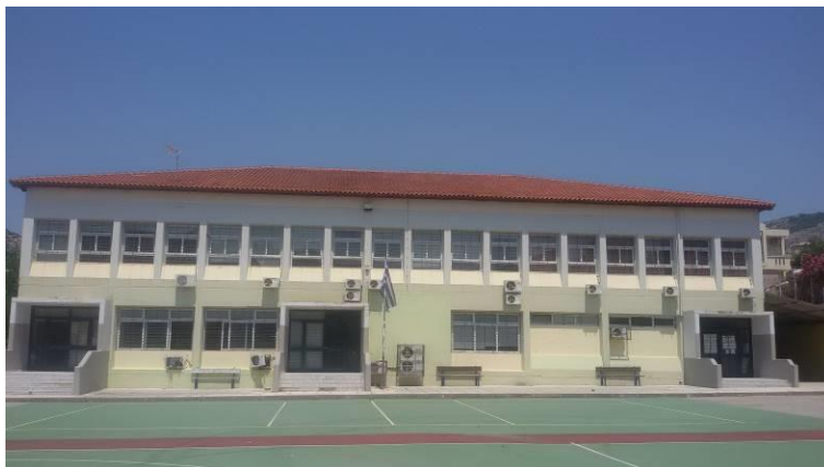
Εικόνα 20. Νοτιοανατολική όψη Λυκείου Φυλής
