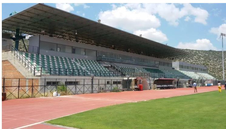
Εικόνα 16. Άποψη ΒΑ κτιρίου κερκίδων
