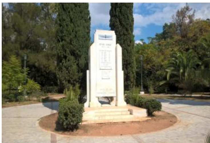
ΚΑΘΑΡΙΣΜΟΣ-ΚΑΛΩΠΙΣΜΟΣ ΔΙΑΔΡΟΜΩΝ ΚΑΙ ΠΑΡΤΕΡΙΩΝ (ΙΕΡΟΣ ΛΟΧΟΣ)-ΜΕΤΑ ΤΙΣ ΕΡΓΑΣΙΕΣ
