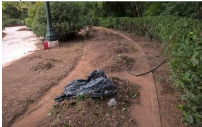
ΚΑΘΑΡΙΣΜΟΣ-ΚΑΛΩΠΙΣΜΟΣ ΔΙΑΔΡΟΜΩΝ ΚΑΙ ΠΑΡΤΕΡΙΩΝ (ΙΕΡΟΣ ΛΟΧΟΣ)-ΚΑΤΑ ΤΙΣ ΕΡΓΑΣΙΕΣ
