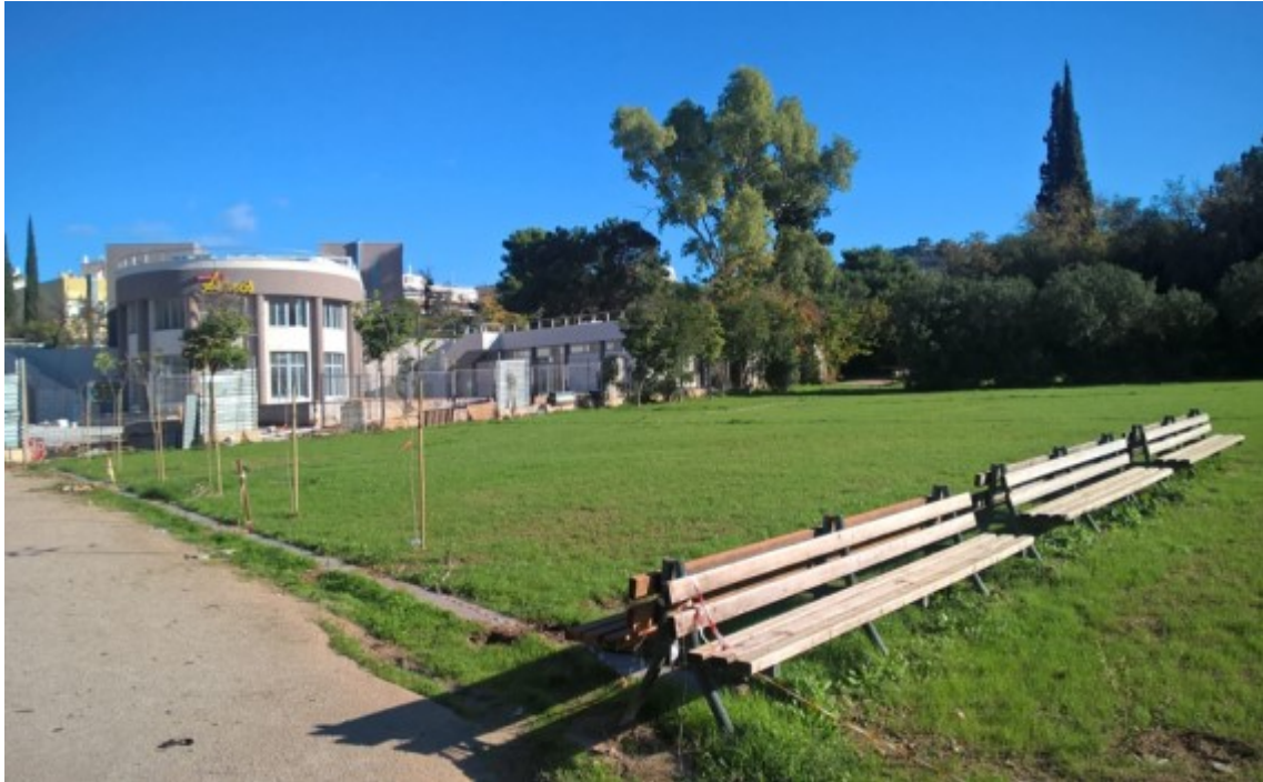
Αποκατάσταση χλοοτάπητα στο Πεδίον του Άρεως
