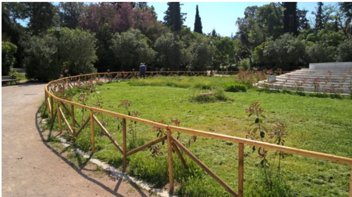
ΕΓΚΑΤΑΣΤΑΣΗ ΞΥΛΙΝΗΣ ΠΕΡΙΦΡΑΞΗΣ
