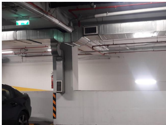
Εικόνα 3.1: Σύστημα εξαερισμού των καυσαερίων στον υπόγειο χώρο στάθμευσης.
