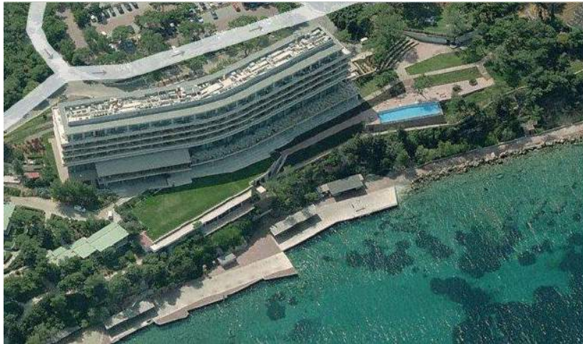
Εικόνα 2.4: Άποψη από Βορειοδυτικά του Ξενοδοχείου «Αρίων» (Πηγή: Bing Maps)
