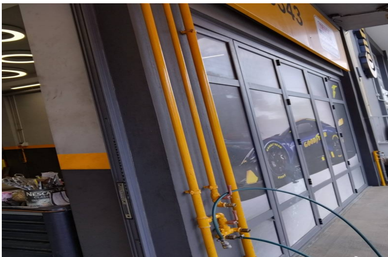
Φωτ.4. Διακρίνονται η ηχομονωτική πόρτα με τον όρο να είναι κλειστή όταν εκτελούνται θορυβώδης εργασίες στο δάπεδο το ανυψωτικό & πιστόλι .
