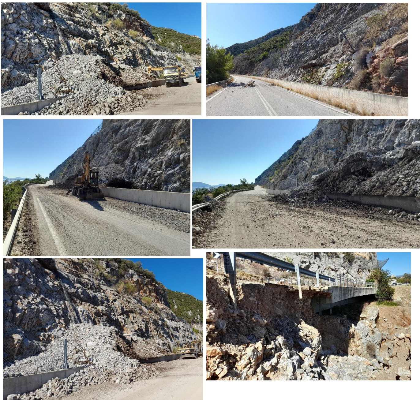
Εικόνα 1. Χαρακτηριστικές λήψεις από τα φαινόμενα αστοχιών που έλαβαν χώρα από 5 έως και 7 Σεπτεμβρίου 2023 λόγω της κακοκαιρίας "Daniel".
