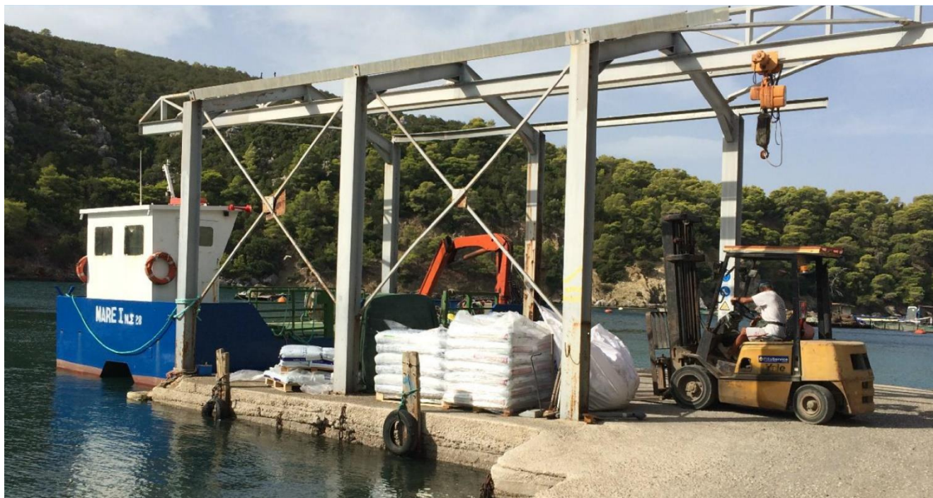
Εικόνα 6.3: Άποψη της γερανογέφυρας επί της εγκατάστασης ελλιμενισμού (προβλήτα)
