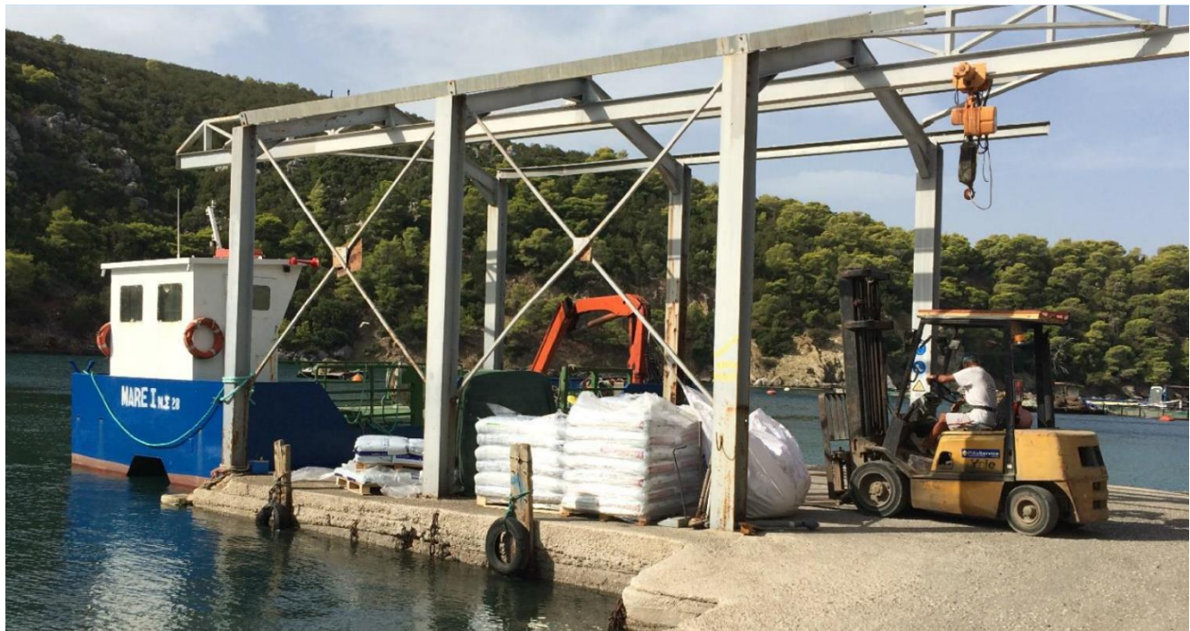
Εικόνα 3: Άποψη της γερανογέφυρας επί της εγκατάστασης ελλιμενισμού (προβλήτα) (πηγή: Τοπογραφικό διάγραμμα που συνοδεύει την ΜΠΕ)
