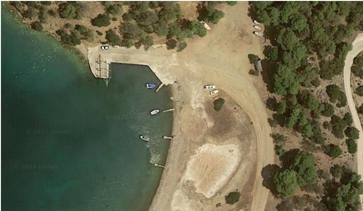
Εικόνα 1: Άποψη των υφιστάμενων έργων στη θέση Πυρκάλι (πηγή: google earth)
