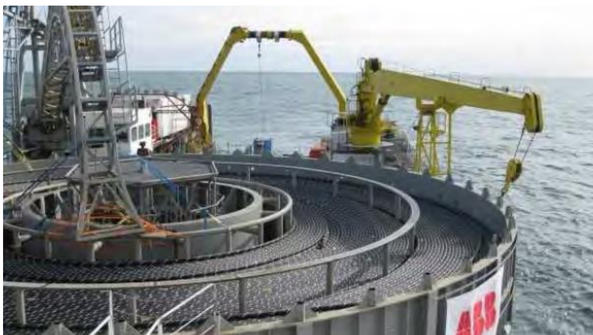
Εικόνα 3.5: Τύμπανο υποβρυχίου καλωδίου επί του ειδικού πλοίου τοποθέτησης υποβρυχίου καλωδίου
