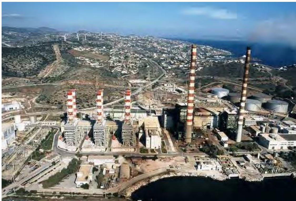
Εικόνα 3.2: Εναέρια φωτογραφία του σημείου προσαιγιάλωσης στον όρμο Θορικού Λαυρίου
