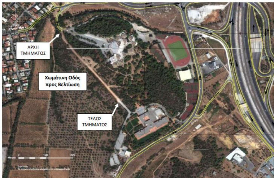
Εικόνα 3.6: Υφιστάμενη χωμάτινη οδός προς βελτίωση (Υπόβαθρο: Google Earth) (Πηγή: ΜΠΕ, 2014)
