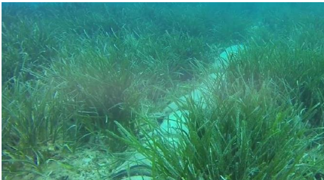
Εικόνα 7.2: Προστασία ορύγματος ΥΚΜ με χρήση τρίχινων σακίων γεμισμένων με άμμο. Τα σακιά αυτά μπορούν να αποτελέσουν υπόστρωμα για την μεταφύτευση ριζών από γειτονικές περιοχές.
