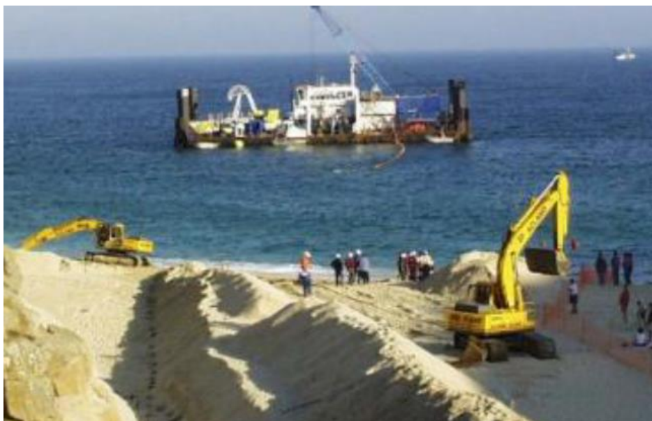
Εικόνα 3.2: Προσאיγιάλωση ΥΚΜ και διάνοιξη τάφρου για τη σύνδεση με υπόγειο καλώδιο μεταφοράς ρεύματος (Πηγή: Tahormina et al., 2018)
