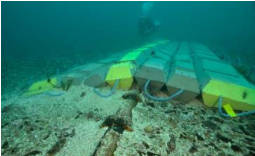
Εικόνα 7.1: Προστατευτικό κάλυμμα με μπετόν σε υποβρύχιο καλώδιο μεταφοράς ενέργειας. (Πηγή Tahormina et al., 2018)
