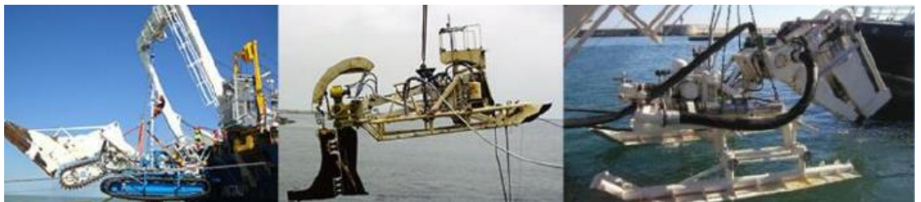
Εικόνα 3.1: Μηχανικός εξοπλισμός που χρησιμοποιείται για την πόντιση καλωδίου (Πηγή: Tahormina et al., 2018)
