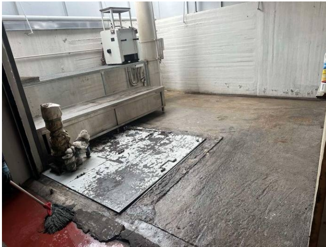
Εικόνα 2: Καθαρισμένος αύλειος χώρος
