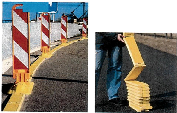
Σχήμα 5.2.2-3: Παράδειγμα οριοθέτησης διαδρόμου κυκλοφορίας (πινακίδες, οριογραμμή και ανακλαστήρες στις βάσεις στήριξης των πινακίδων)
